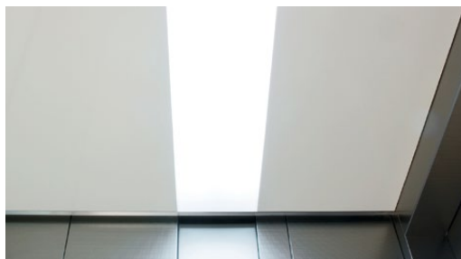
Moduldecke mit LED-Stripes hinter Plexiglas
