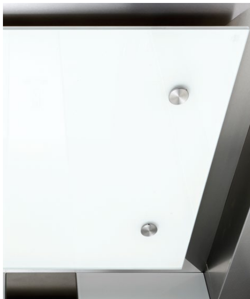
Abgehängte Decke mit blickdichtem Glas
