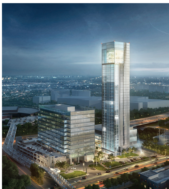
Torre de Testes - TK Elevator Atlanta, EUA
