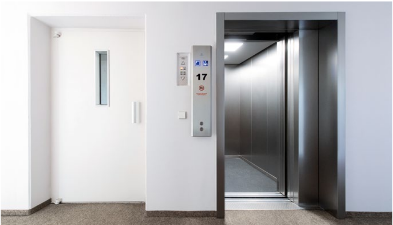
Abb.9: Alte und neue Aufzugtüren im direkten Vergleich
